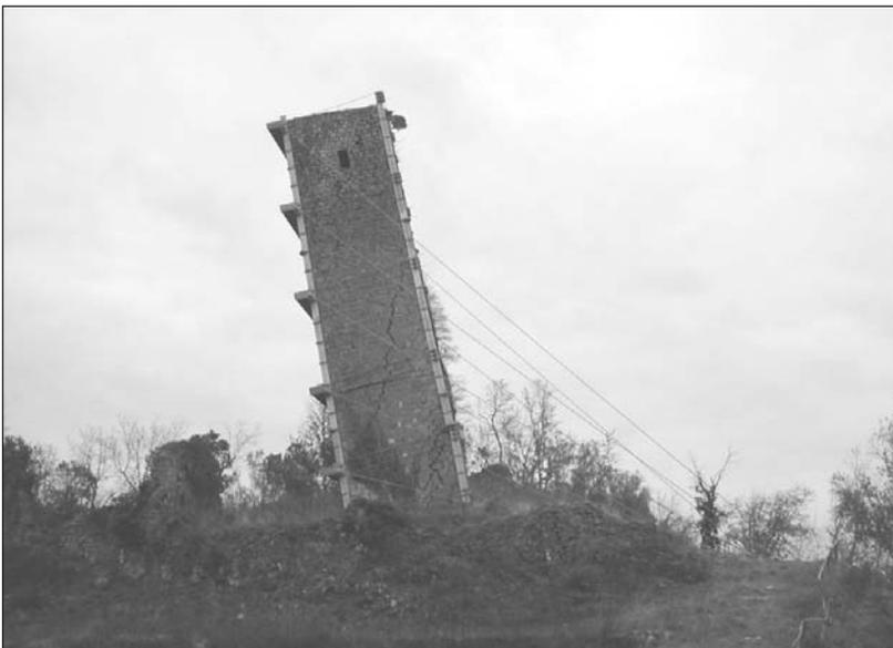
Fig. 10 - Per sostenere il peso della Torre, contrastandone la caduta, è stata allestita una gabbia d'acciaio tirantata e ancorata ad un blocco di calcestruzzo.
